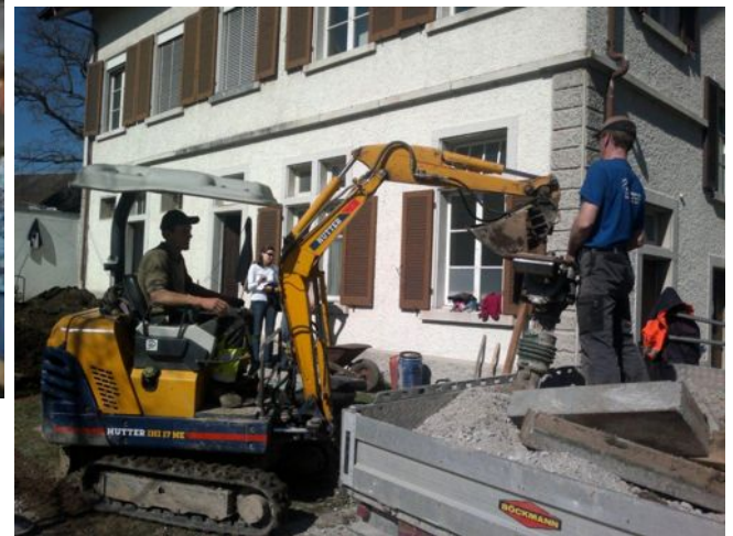
Stefan Schenkel beim Umbau des Spielplatzes
